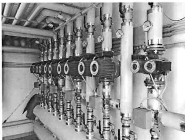
La centrale termica è stata recentemente adeguata; i circuiti in partenza realizzati con pompe gemellari sono ben coibentati.
