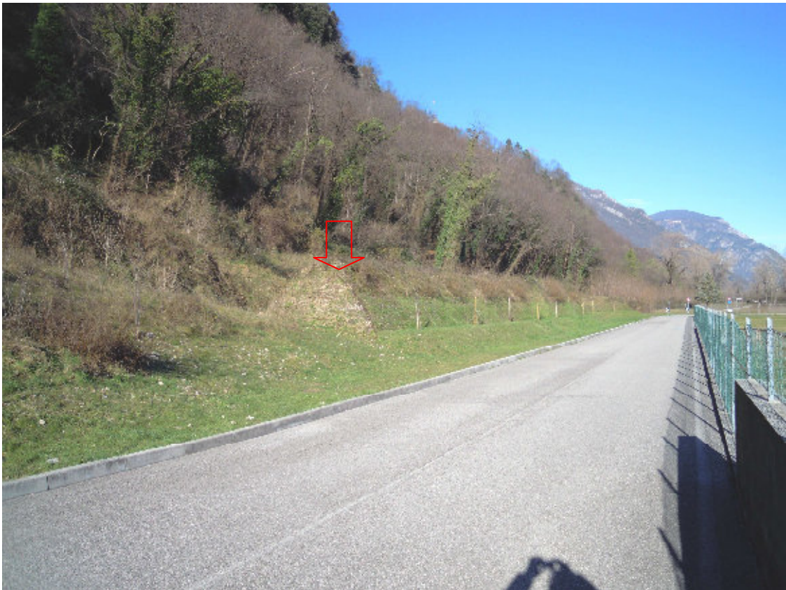
VALLO-RILEVATO PARAMASSI A PROTEZIONE DEL POLISPORTIVO COMUNALE
