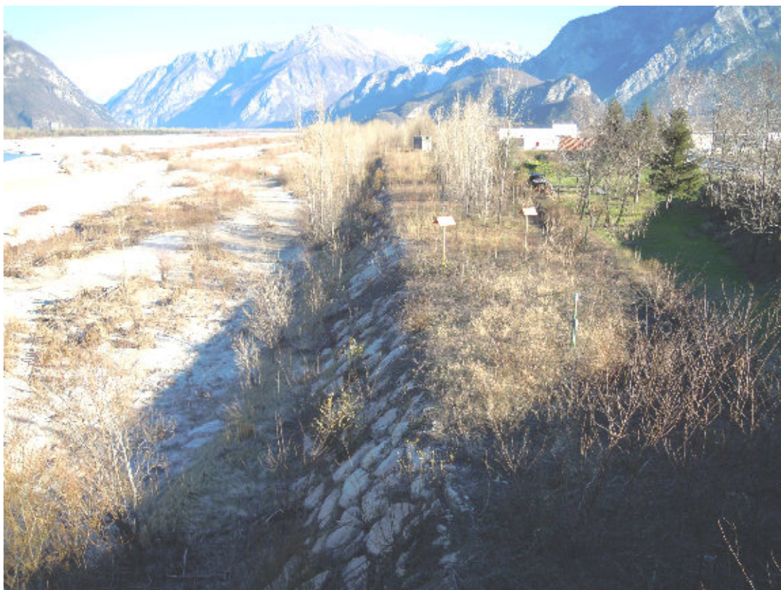
RILEVATO ARGINALE A NORD DEL PONTE DI BRAULINS
