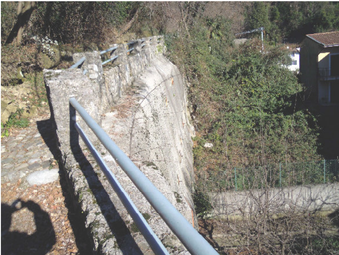
PARETE ROCCIOSA CONSOLIDATA CON SPRITZBETON E CHIODATURA ALL'ESTREMITA' OCCIDENTALE DEL CENTRO STORICO DI OSOPPO
