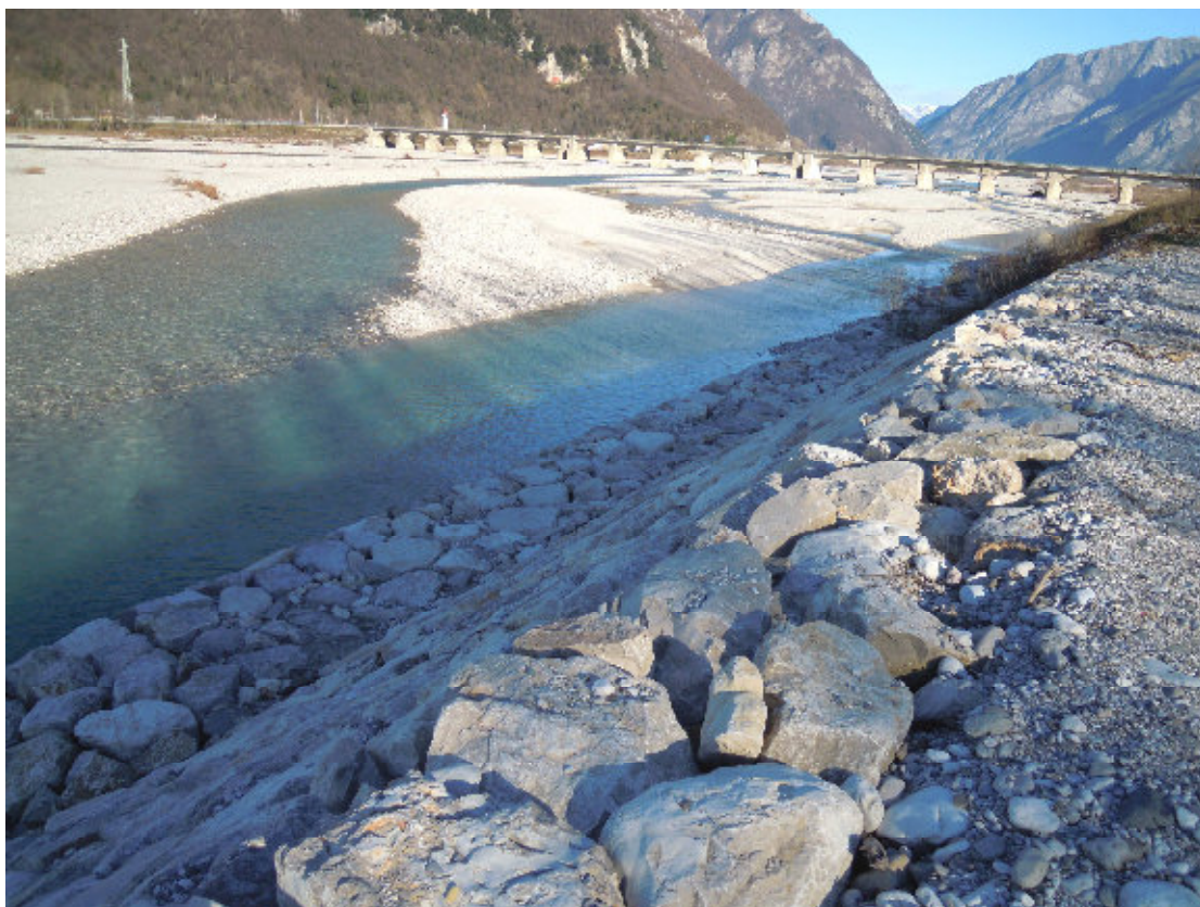
SPONDA CONSOLIDATA NEL 2014 IN LOCALITA' PINETA, IMMEDIATAMENTE A VALLE DEL PONTE DI BRAULINS
