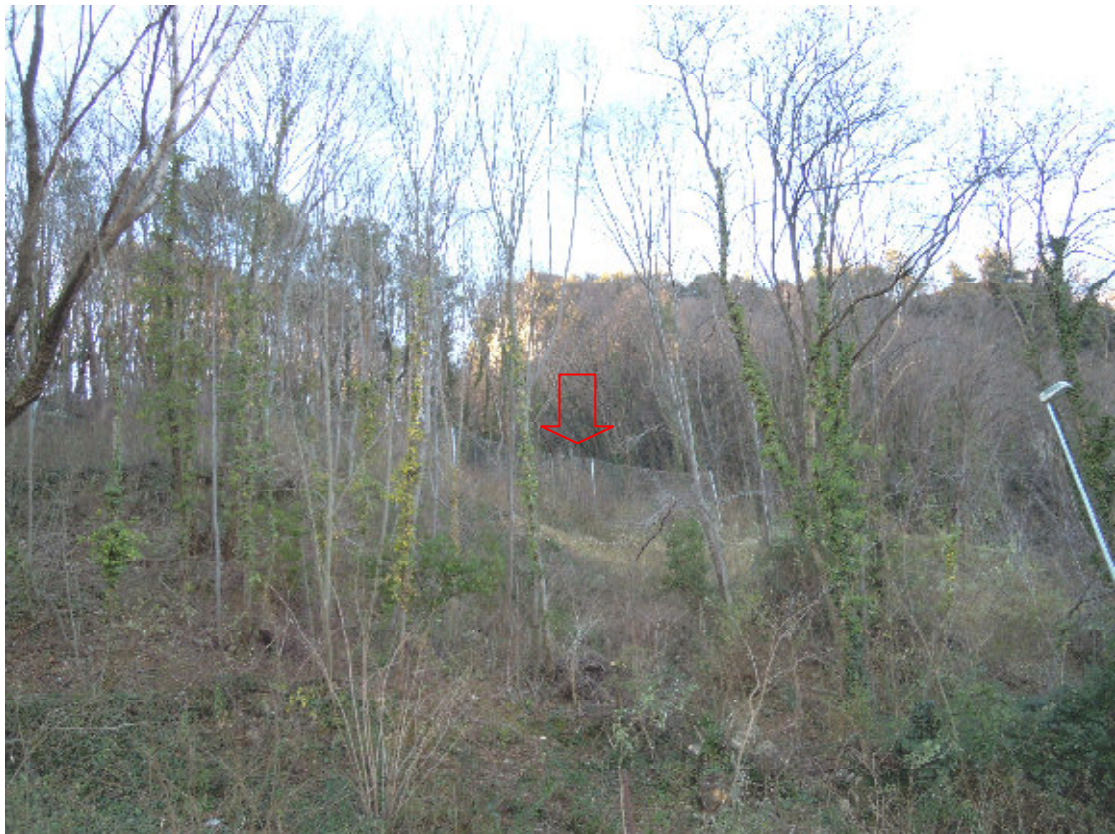
RETE METALLICA PARAMASSI INSTALLATA A MONTE DI VIA MOSCOVIA
