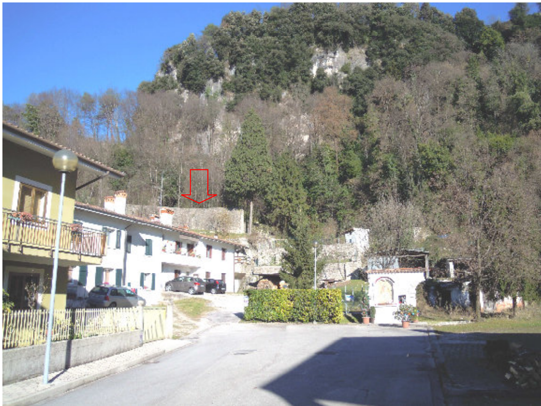
MURO IN CEMENTO ARMATO A PROTEZIONE DI UN EDIFICIO RESIDENZIALE ALL'ESTREMITA' NORD-OCCIDENTALE DEL CENTRO STORICO DI OSOPPO
