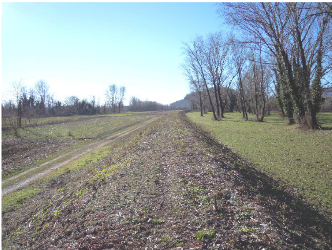
RILEVATO ARGINALE AD OVEST DELL'ABITATO DI PINETA
